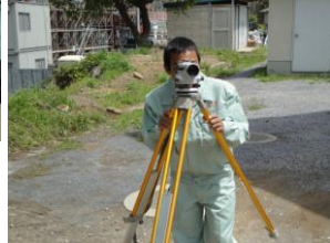
レベルによる高さの測定
