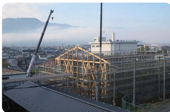
▲基礎工事が終わり、建屋建設中の多目的競技場
