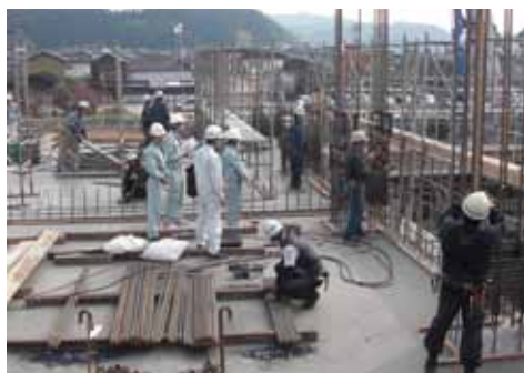
インターンシップ(配筋確認検査の体験)
