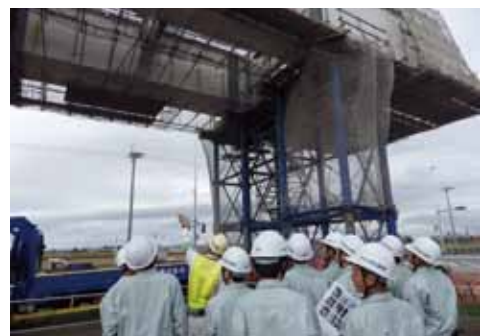
現場見学(橋梁架設工事現場の視察)
