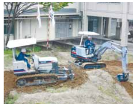
建設機械実習
