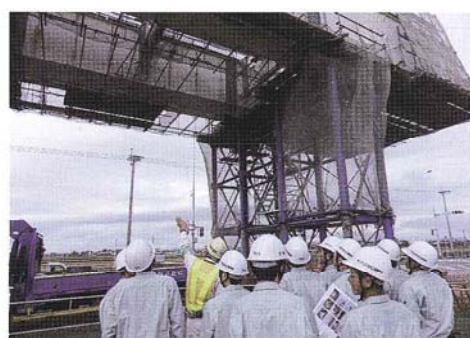
現場見学(橋梁架設工事現場の視察)
