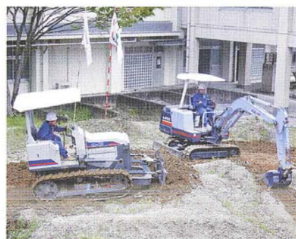
建設機械実習
